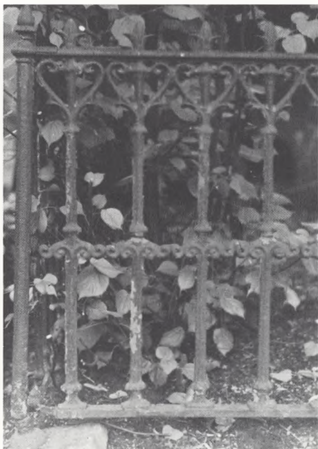
Gitter med svage stolper, uden sokkel, kun en blok i hvert hjørne, meget gammelt (1814).
