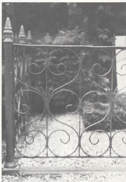
Rørstolpetype med rundjernstave og -spiraler, ca. 1897.
