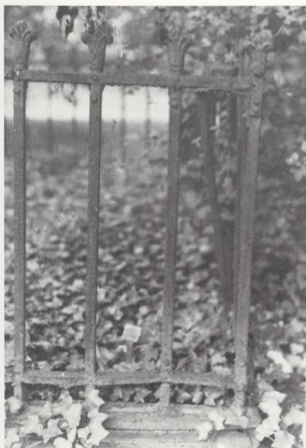
Dette gitter er samlet ved nitning af et båndjern på bagsiden, meget gammel, måske det ældste (1809).
