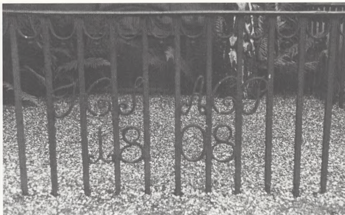
Smedejernsgitter fra ca. 1803 med diagonal stillede stave.
