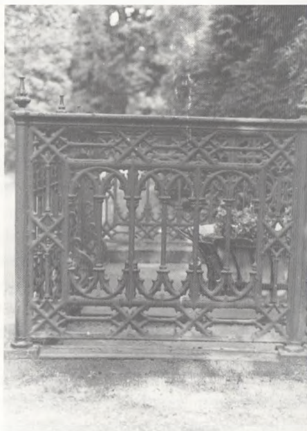
Sokkel af tredelt type og stolpe har fod.
