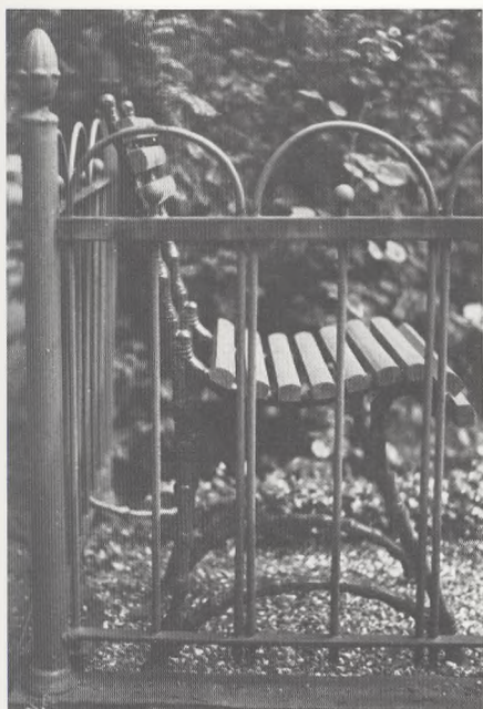
Rørstolpetype med vinkeljernsås foroven, fra 1907, lavet af Petersen og Brill, Gothersgade 14.
