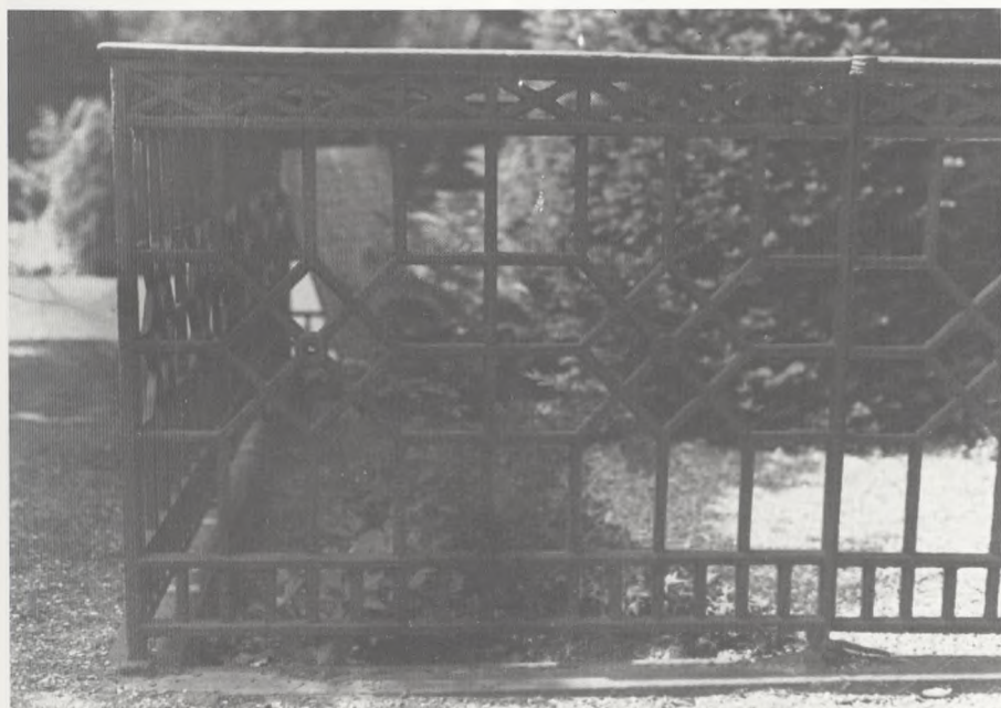
Gitter i geometrisk form, samlet ved sammennitning af sektioner, ensidigt støbt, gammelt.
