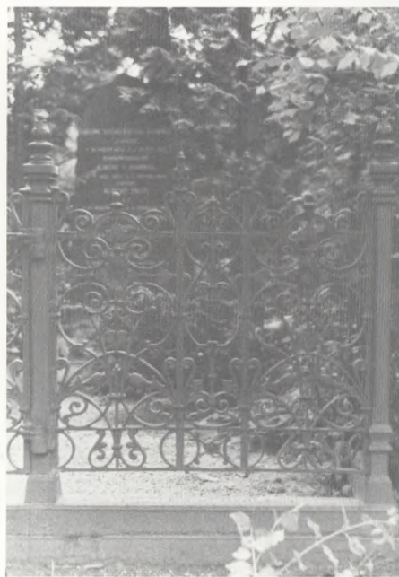
Et art nouveau gitter med pånittede blikrosetter.
