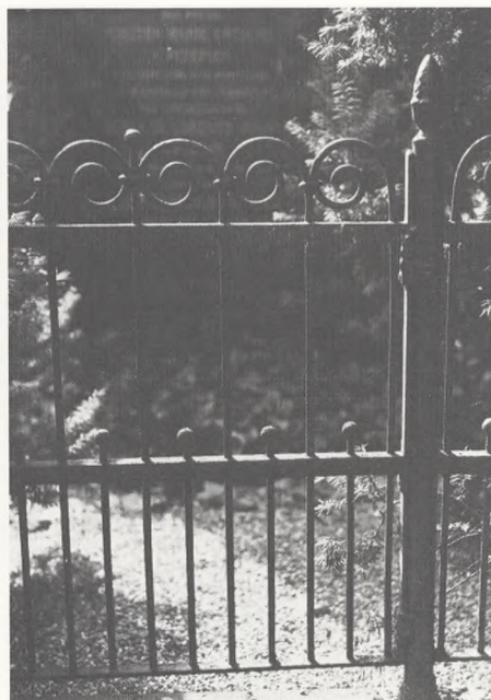
Rørstolpetype med 2 vinkeljernsåse, fra 1907, lavet af Petersen og Brill, Nørrevold 78.
