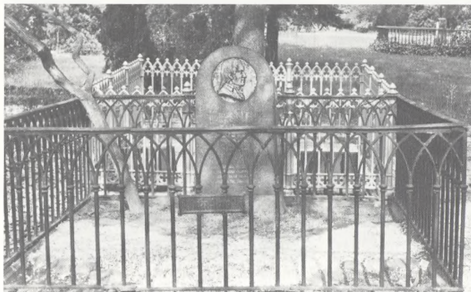
Smedejernsgitter, med støbejernssokkel mærket Ludvigsen og Herman, gravstedet genoprettet 1882.
