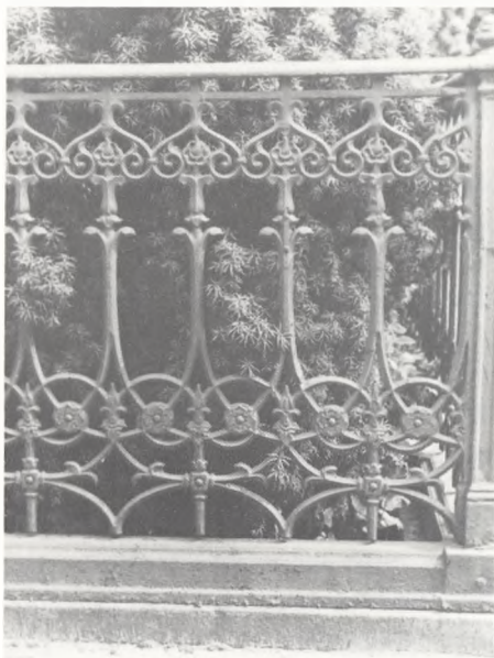
Sokkel af to dele, nederst granitsokkel og derover støbejernssokkel, bolt er anvendt ved hjørne samlingen.
