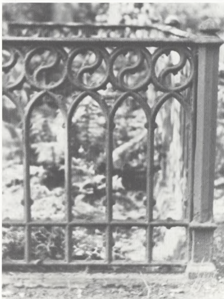
Affaset stolpe, gitterværket tappet til stolpen.
