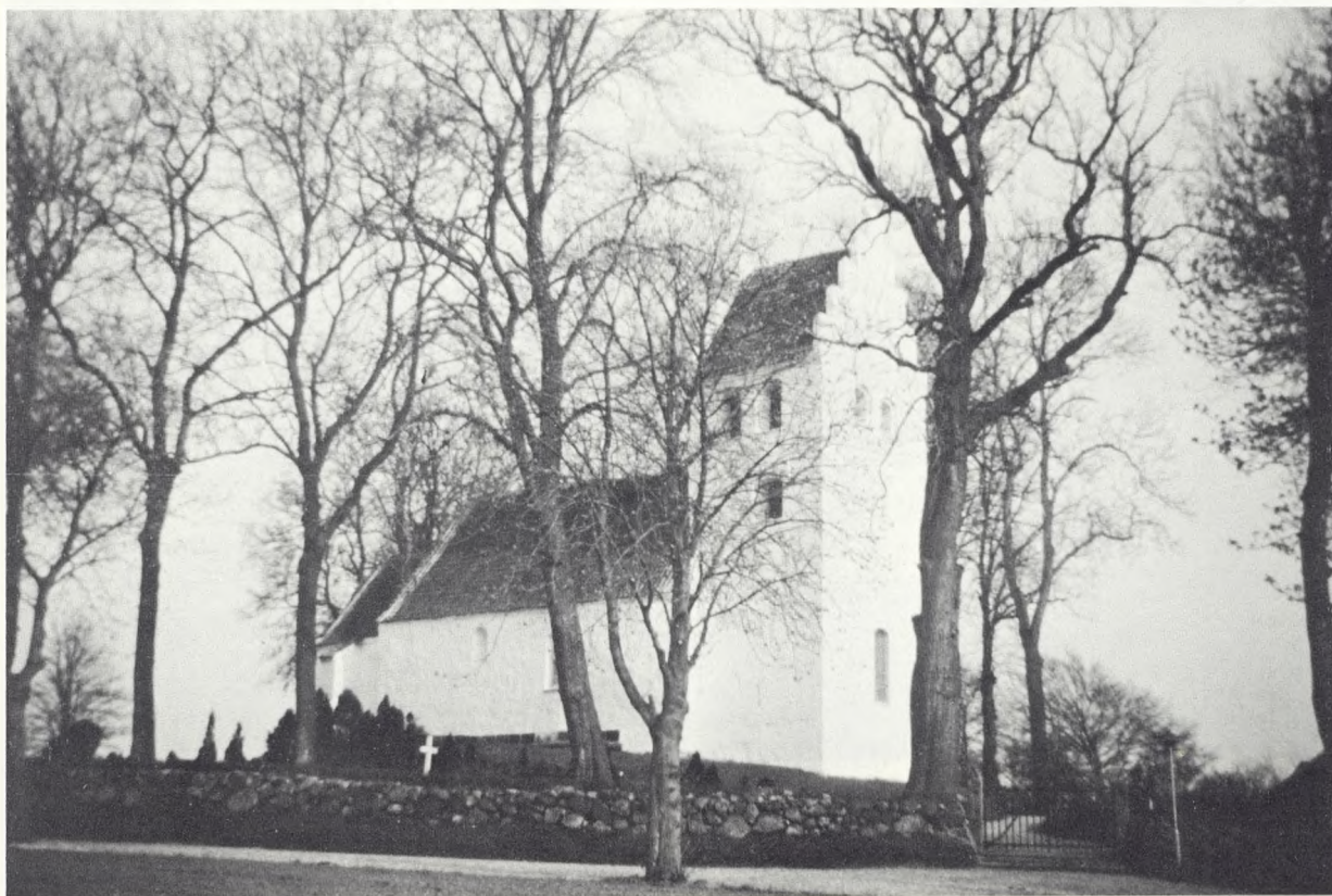
Fig. 115 Landsbykirken og kirkegården med de gamle træer og kampestensdiget. (Stenløse, Odense amt). Forfatteren foto.
