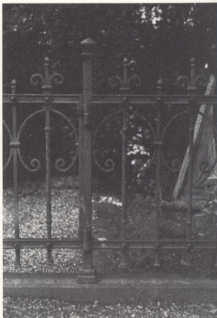
Firkantstolpetype fra omkring 1908, serieproduktion.
