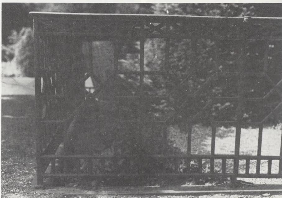
Gitter i geometrisk form, samlet ved sammennitning af sektioner, eensidigt støbt, gammelt.
