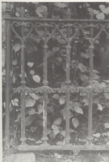
Gitter med svage stolper, uden sokkel, kun en blok i hvert hjørne, meget gammelt (1814).
