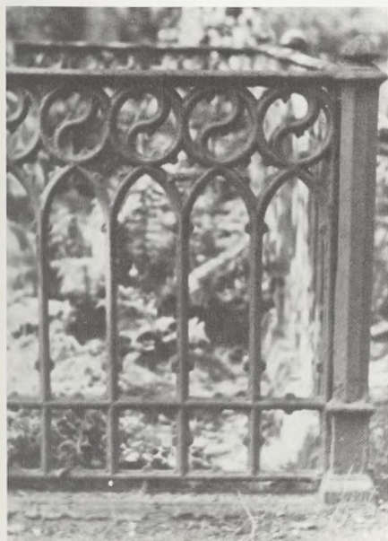
Affaset stolpe, gitterværket tappet til stolpen.
