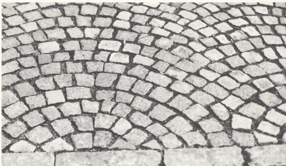
Chaussebrostenbelægning med græsfuge, lagt i buemønster. (Foto: M. Falmer-Nielsen 1974)
