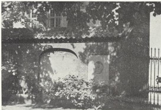
19. St. Petri kapel. Muren imod Nørregade.
