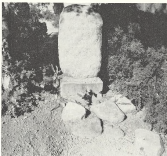
4. Naturstenen er anbragt for højt. Soklen er synlig. Foto: Forf.
