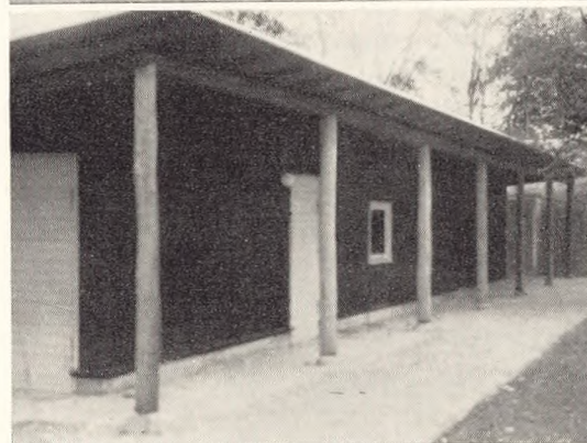
Fig. 158. Bygning for opsyn m. m.
