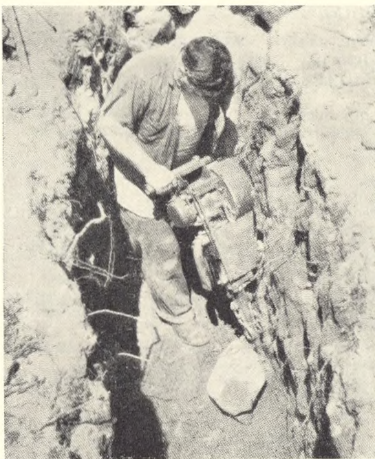
Fig. 204. Der arbejdes med trykluftredskaber.
