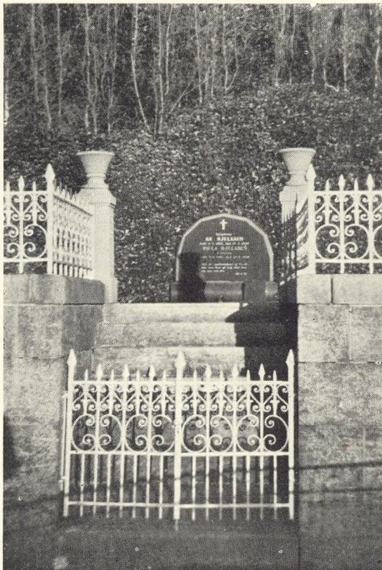
Fig. 64. Opgang og Støttemure ved Familiegravsted.
