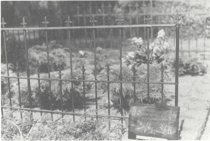
Smedejernsgelænder med topstykke i støbejern. Der er i dette gelænder anvendt to forskellige topstykker. (Foto: AHM).
