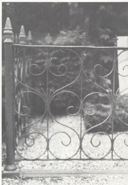
Rørstolpetype med rundjernstave og -spiraler, ca. 1897.
