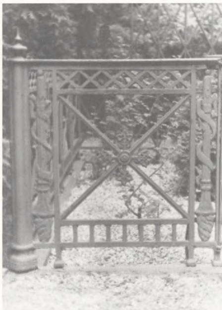
Stolpe er sammensat, mellem-stolper bruges ikke men felter med fakkler, gitterfaget har derfor ben.
