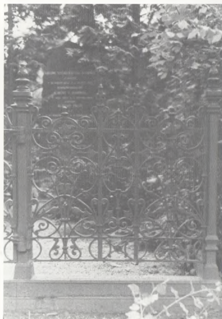
Et art nouveau gitter med pånittede blikrosetter.
