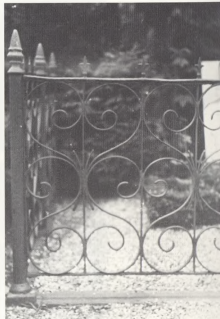
Rørstolpetype med rundjernstave og -spiraler, ca. 1897.
