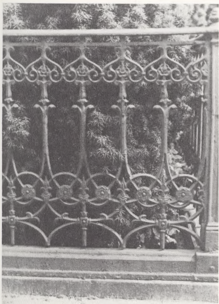
Sokkel af to dele, nederst granitsokkel og derover støbejernssokkel, bolt er anvendt ved hjørne samlingen.
