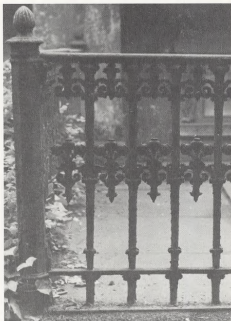
Stolpe er her ottekantet med vulster, gitterværk samlet ved bladning. Naturaliserende type fra 1847.
