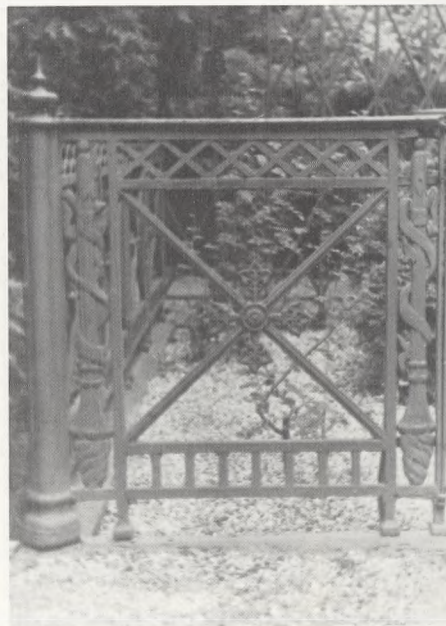
Stolpe er sammensat, mellem-stolper bruges ikke men felter med fakkell, gitterfaget har derfor ben.
