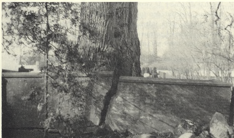
Fig. 10. Den indre træække står ofte for tæt på muren. Enten må træet eller muren vige. Lyderslev, Præstø amt. (foto T. M.)
