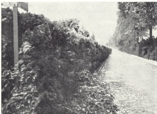
Fig. 87. 30-årig thujahæk , løs og udhængende, dømt til rydning.
