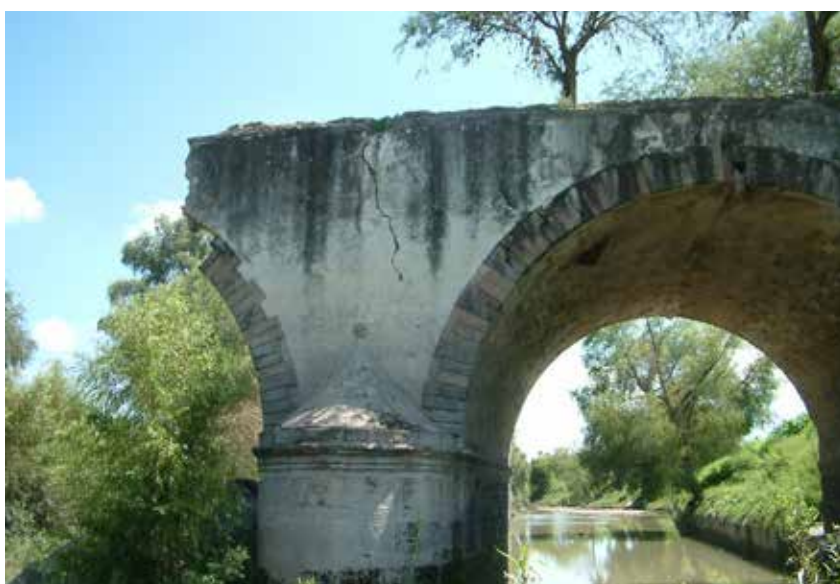
San Rafael broen: Broen blev bygget henimod slutningen af 1700-tallet og fungerede indtil 1980, hvor vandmasserne fra floden Laja fik to af broens buer til at falde sammen. Broen består af en overordentlig kraftig stenkonstruktion. Indgående i Kongevejen er den ligesom Puente del Fraile omfattet af UNESCOs Verdensarvliste. Reference: UNESCO site, foto: Jesus Ibarra
