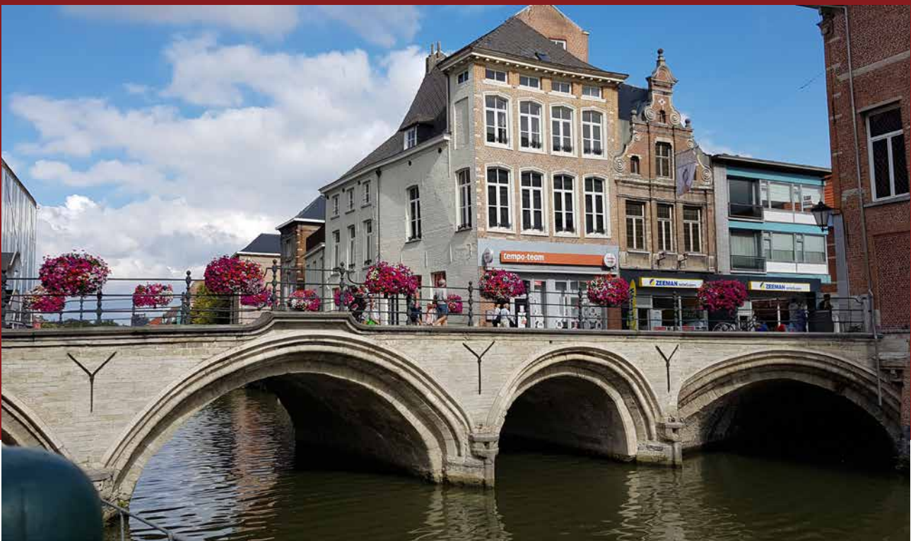
Grootbrug eller Hoogbrug i Mechelen er en af de ældste stenbyggede broer i Flandern, der stadig er i brug. Den er opført af sandsten i det 13. århundrede men er i nyere tid blevet forstærket med en betonplade for at kunne bære den kørende trafik. Foto: Per Winther.
