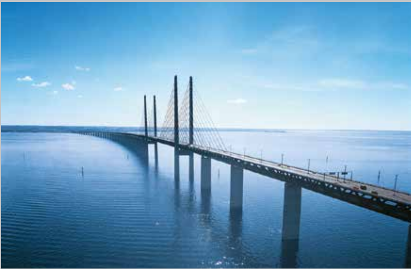
Den 7,8 km lange Øresundsbro fra 2000 har et skråstagshovedspænd på 490 m. og har både motorvej på øverste dæk og jernbane på underste dæk. Foto: Sund & Bælt.
