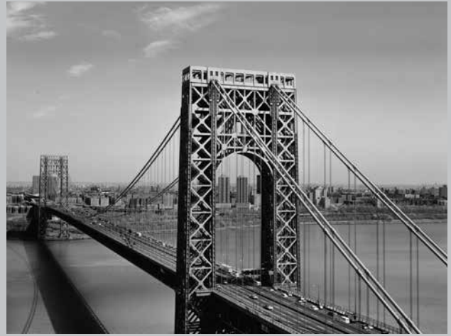
Hængebro. Vejbroen George Washington Bridge i New York fra 1931. Fotografiet er fra 1978, hvor en påbygget ekstra vejbane kan ses. Foto: Jack Boucher, Historic American Engineering Record /HAER) collection.
