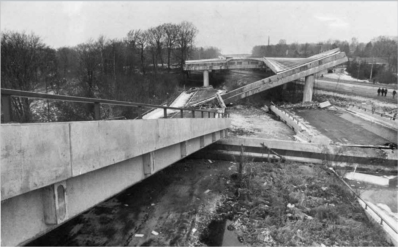
Den ødelagte Fiskebækbros i 1972. Broen havde stået færdig i et år, da tre fag pludselig kollapsede. Heldigvis var motorvejen på broen endnu ikke taget i brug. Foto: Karl Høver. Scanpix.
