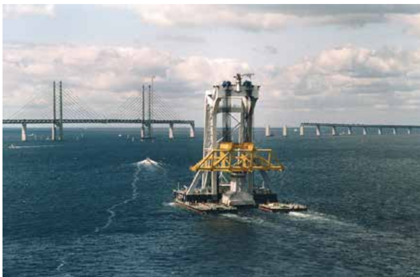
Øresundsbroens underdel bygget som præfabrikerede betonsænkemasser transporteret med den ombyggede "Svanen" flydekran som nu var på sin tredje anvendelse til brobygning. Foto: COWI.
