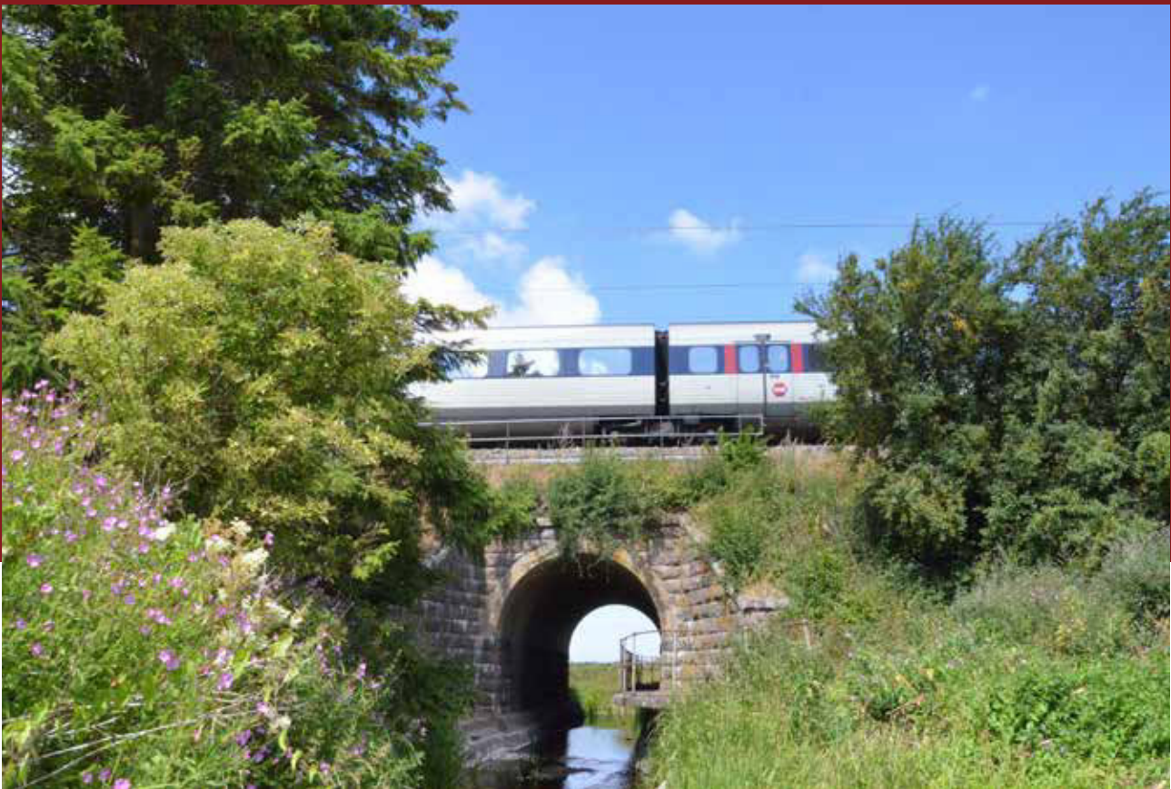
Tuel Å Bro. Da jernbanen i 1850'erne blev anlagt mellem Roskilde og Korsør blev der anlagt en buebro så Tuel Å kunne føres under banen. Jernbanen mellem København og Korsør er udpeget som et nationalt industriminde. Foto: Lars Bjarke Christensen.
