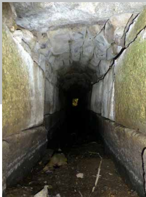
Fig. 7: Det indre af stenkiste nr. 3 med det tøndehvælvede loft af kilesatte sten. Foto: Per Lotz.
