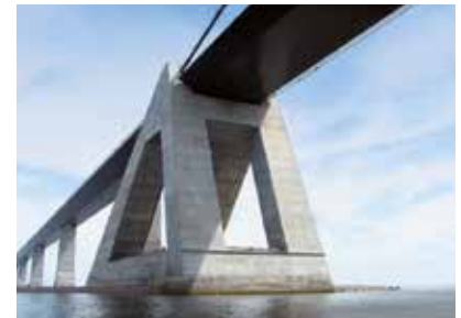
Den monumentale og skulpturelle ankerblok for Østbroen ved Storebælt er udformet med henblik på optimal kraftoverføring til undergrunden og udførelsesteknik og samtidig have minimal visuel påvirkning. Foto: COWI.
