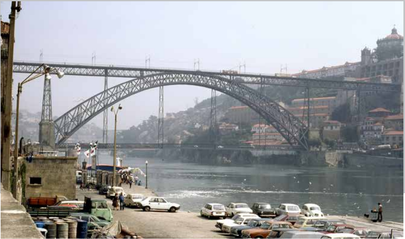
Vejbroen (i to niveauer) Dom Luiz I over floden Duoro i Portugal, konstrueret 1881-86 af Theophile Seyriq og Leopold Valentin. Højde 45 m, spændvidde 172 m, samlet længde 395 m., benyttes nu som cyklist- og fodgængerbro. Foto 1981: Lars Martin Nilsson.
