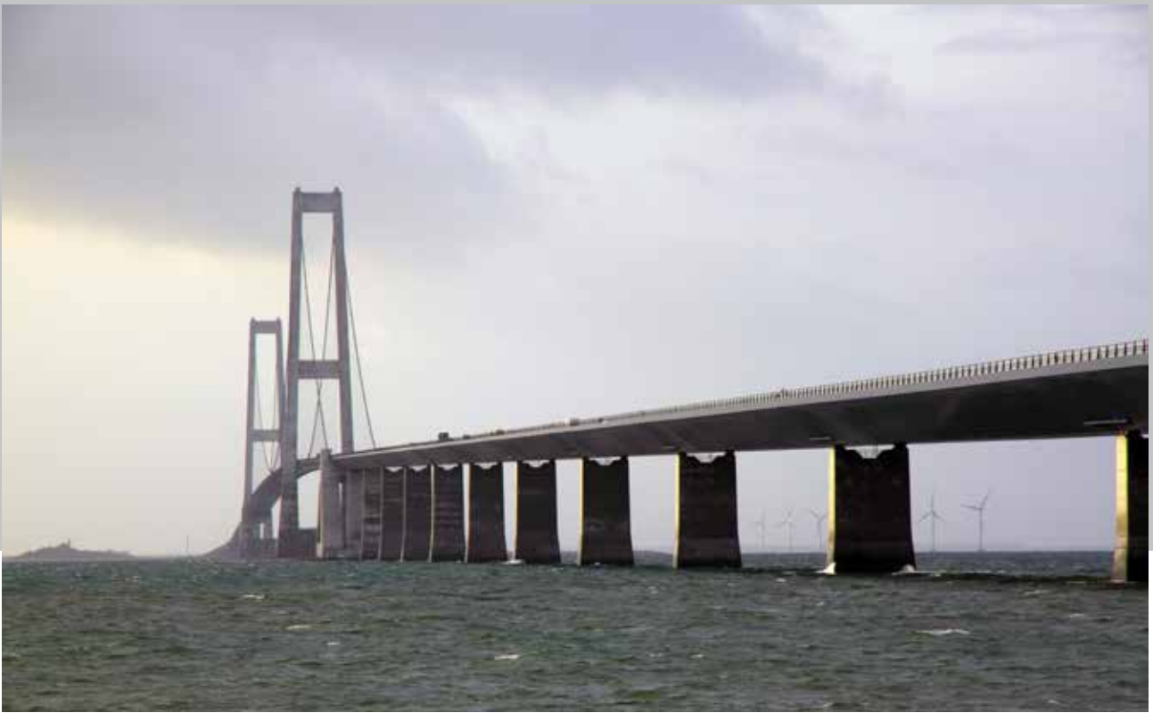
Storebælt forbindelsen fra 1998 er 19 km lang med dens østlige banetunnel og hængebro for biler og den vestlige bro til både bil og tog. Den 7 km lange Østbro har et hovedspænd på 1.624 m som var verdensrekord indtil den japanske Akashi bro åbnede. Foto: Sund & Bælt.
