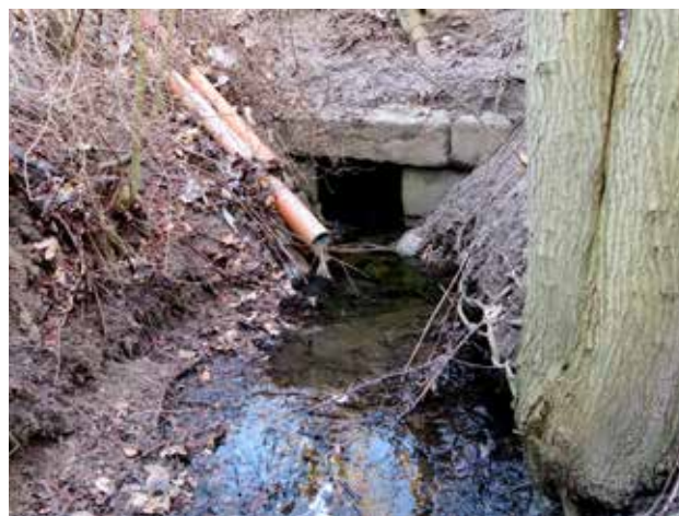
Fig. 8: Stenkiste nr. 4 over Brådebækken ved Ubberød Dam. Østsiden med skæmmende rør af plast. Foto: Per Lotz.
