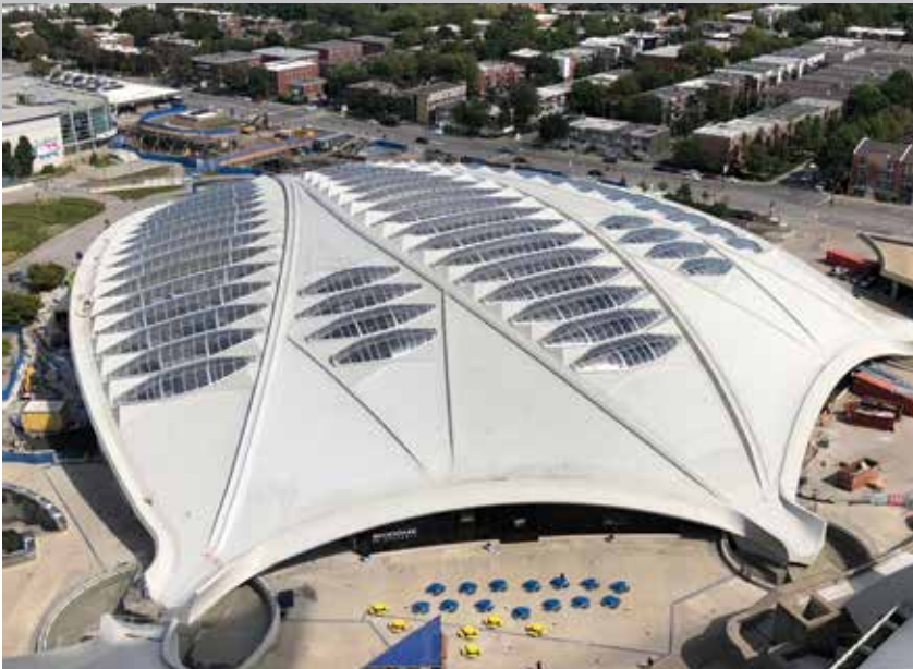
Velodromen for de olympiske lege i Montreal 1976 var en udfordrende konstruktion udformet som en kompliceret sammensat flad skalkonstruktion med et frit spænd på 172 m og en samlet vægt på 37.000 ton. Den blev løftet af sine mere end 10.000 stilladsunderstøtninger ved et helt unikt system af 226 såkaldte "flat jacks" Ø 920 mm, der arbejder med et tryk på op mod 170 bar. Foto: Fishhead64.
