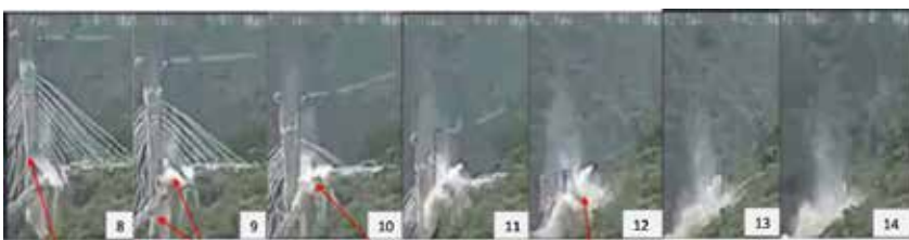
På det øverste billede af Chiraja broen i Columbia ses den ene del af en skråstagsbro under konstruktion. Den anden del ligger i ruiner til højre forårsaget af et forkert design. Nederst ses billeder fra ulykken taget fra en video. Ulykken i 2018 skete i frokostpausen, hvorfor kun ti- og ikke hundrede – arbejdere blev dræbt. Foto: Modjeski and Masters.
