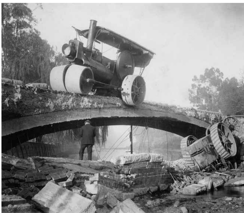
First King's bro i Bendigo, Australien, bestod ikke i 1901, da to damptrømler testede konstruktionen. Halvdelen af betonbroen faldt sammen. University of Melbourne Archives 1964.0012.00260.
