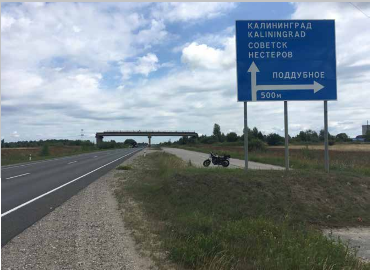
Den russiske strækning fotograferet fra syd mod nord i retning af byen Kaliningrad i Kaliningrad- eksklaven. De to spor i venstre side er den nuværende E28. De to spor til højre er den originale betonbelægning. Broen over vejen er opført af russerne, men er aldrig blevet færdiggjort (Poul Holt Pedersen 2018).
