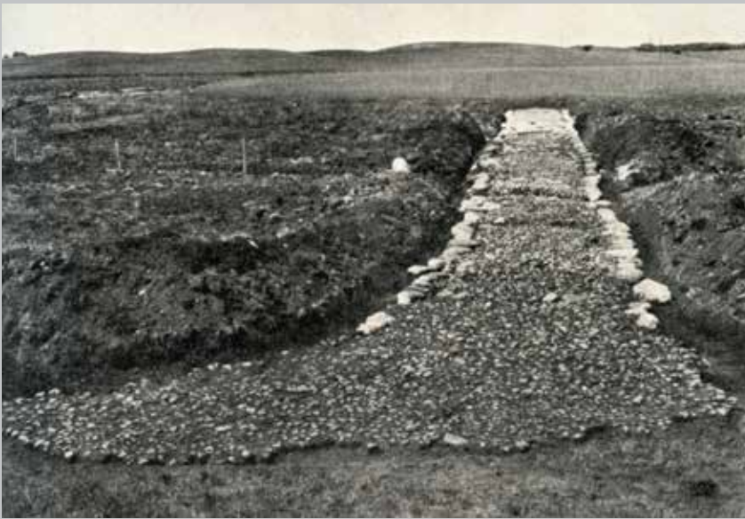
Fig. 5. Vejdæmningen efter afdækningen i 1930. Efter Brøndsted 1936, fig. 2.
