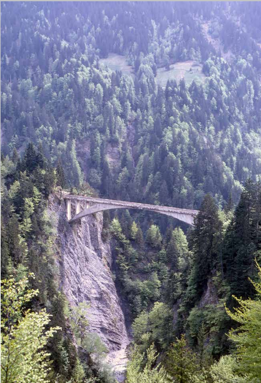
Salginatobelbrücke, Schiers. 1930. Design: Robert Maillart. Foto: Forfatteren.
