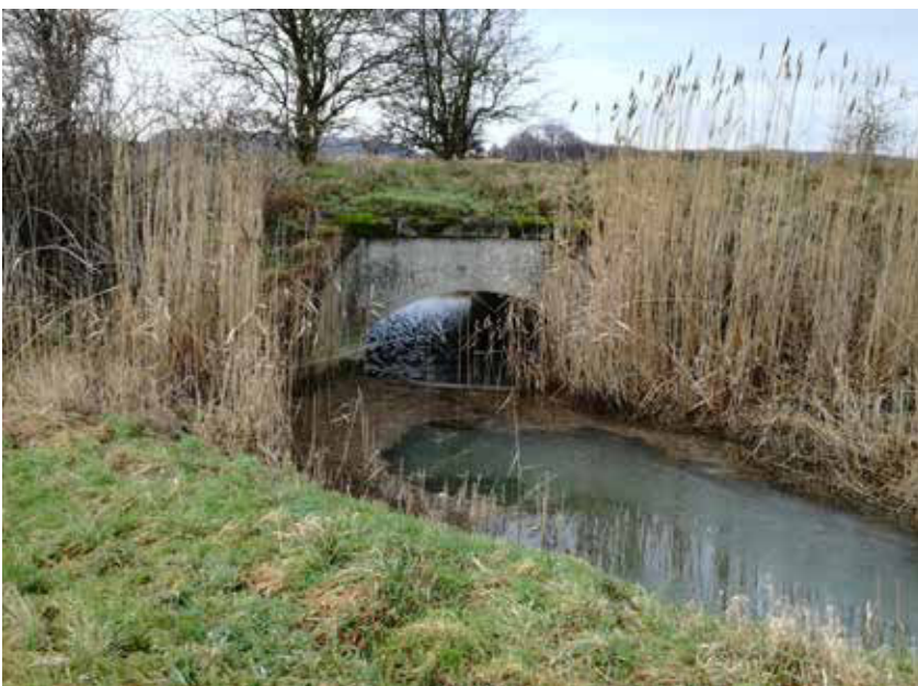
Roebanebro Nakskov. Roebanedæmning med betonbro nord for Nakskov. Foto: Anders Jon Nielsen
