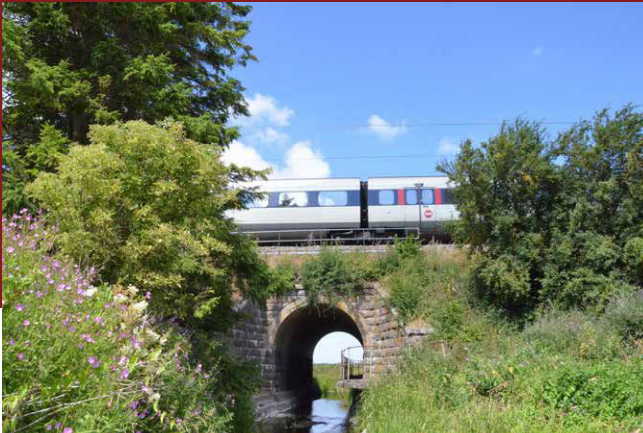
Tuel Å Bro. Da jernbanen i 1850'erne blev anlagt mellem Roskilde og Korsør blev der anlagt en buebro så Tuel Å kunne føres under banen. Jernbanen mellem København og Korsør er udpeget som et nationalt industriminde. Foto: Lars Bjarke Christensen.
