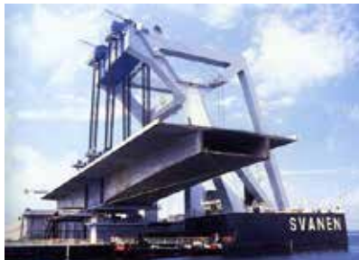
Montage af præfabrikeret broelement for Vestbroen i Storebælt på ca. 6.000 t med flydekranen "Svanen". Vestbroen er udformet som et unikt samlesæt af 324 elementer af pille-sænkekasser, søjler og brodragererlementer fabrikeret på land og placeret på brostedet med den specialbyggede "Svanen" Foto: Sund & Bælt.
