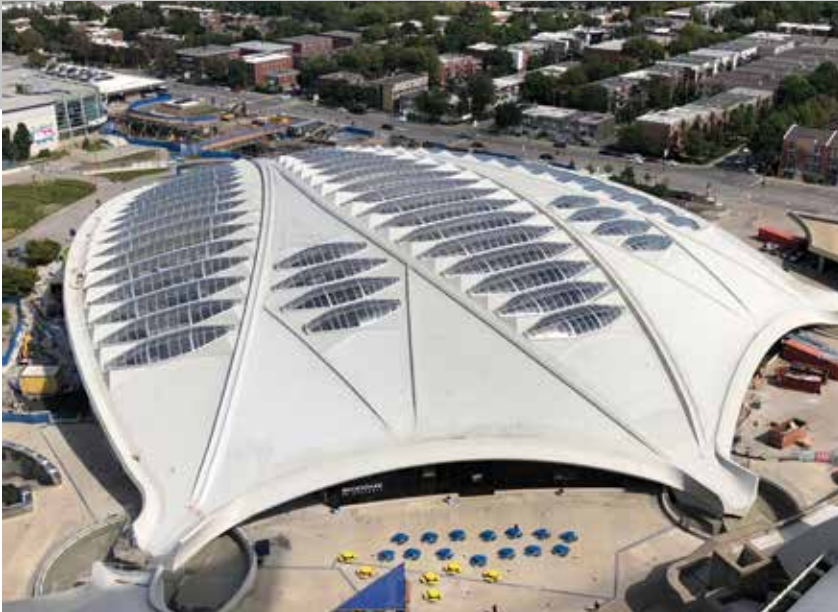
Velodromen for de olympiske lege i Montreal 1976 var en udfordrende konstruktion udformet som en kompliceret sammensat flad skalkonstruktion med et frit spænd på 172 m og en samlet vægt på 37.000 ton. Den blev løftet af sine mere end 10.000 stilladsunderstøtninger ved et helt unikt system af 226 såkaldte "flat jacks" Ø 920 mm, der arbejder med et tryk på op mod 170 bar. Foto: Fishhead64.
