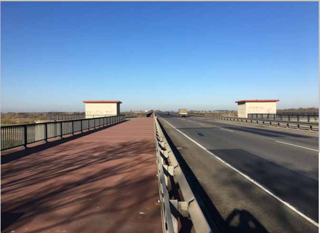
Most Knybawski broen. Broen er forberedt til fire spor, men der er kun lavet to. Der er bunkere på hver side af vejen. (Poul Holt Pedersen 2018)
