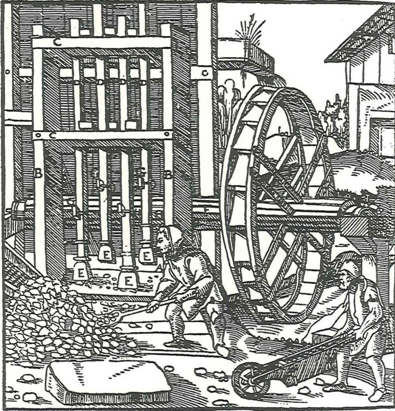
Knuseværk efter Agricola.
