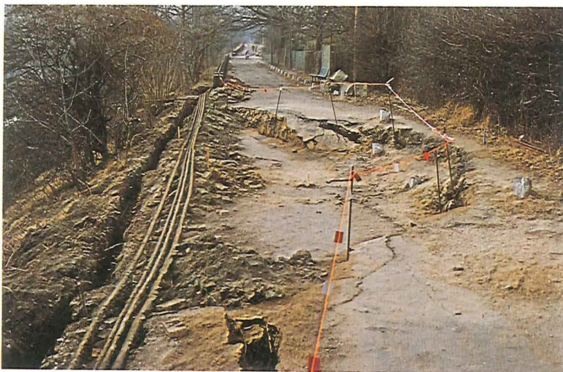
Figur 4. Skreddets udseende sidst i februar kort før morænelerets bortgravning.
