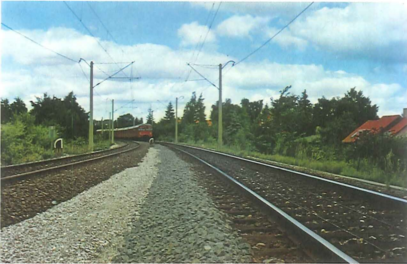
Fig. 9. Svelfefundament af Rønne granit. På højre spor er netop udlagt et nyt fundament af Rønne granit. Det venstre spor er rustfarvet af slidet på spor og hjul. Imellem de to par skinner er der fyldt op med stabilgrus fra en kvartær smeltevandsaflejring. Billedet er fra Farumbanen mellem Dyssegård og Vangede station.
