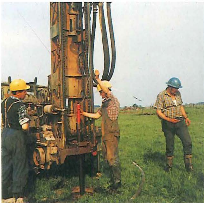
Figur 2. Efter sprænghullet er boret, sænkes ladningen ned.
