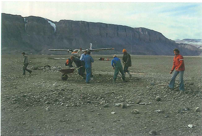
Figur 4. Der ryddes sten og jævnes ud til landingsbane for ekspeditionernes Twin Otter fly. Foto: N. Henriksen.
