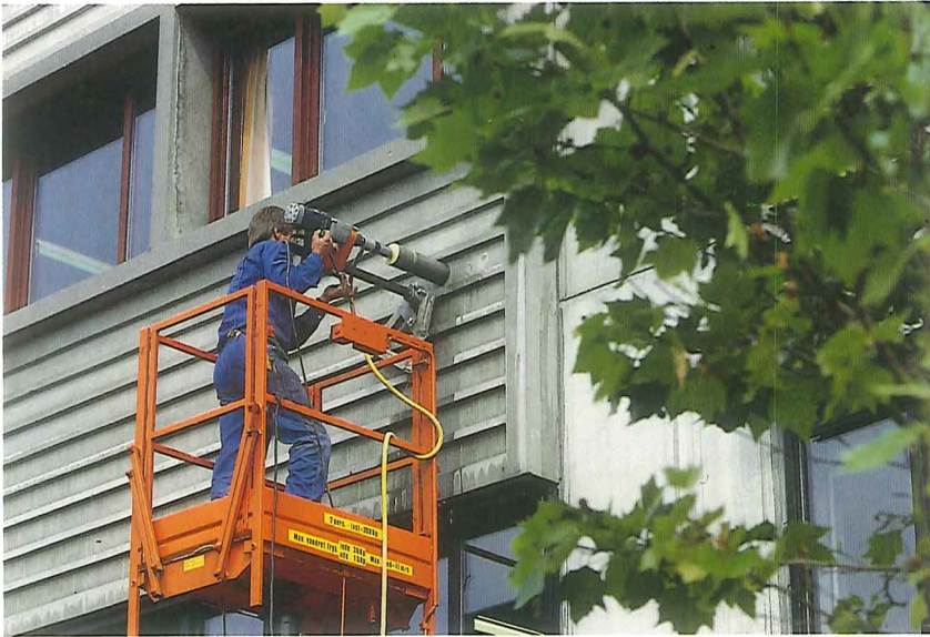
Figur 3. Udboring af betonkærne til undersøgelse af skadesramt beton.
