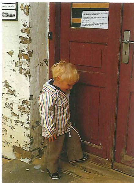
Figur 5. Klitterne ligger helt ind over dørtrinnet ved indgangen til sandflugtsmuseet i maskinhuset under Rubjerg Fyr.
