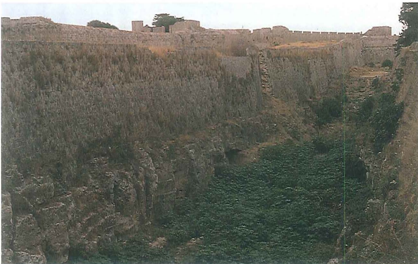
Figur 4a. Fæstningsmur og voldgrav omkring middelalderbyen Rhodos. Terrasserne på voldgravens sider er ar efter brydningen af stenene til muren og borgen.
