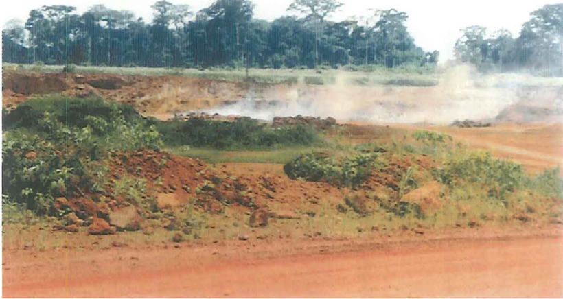
Figur 5. Bauxiten er stedvis meget hård og må derfor sprænges med dynamit som her i Awaso.
