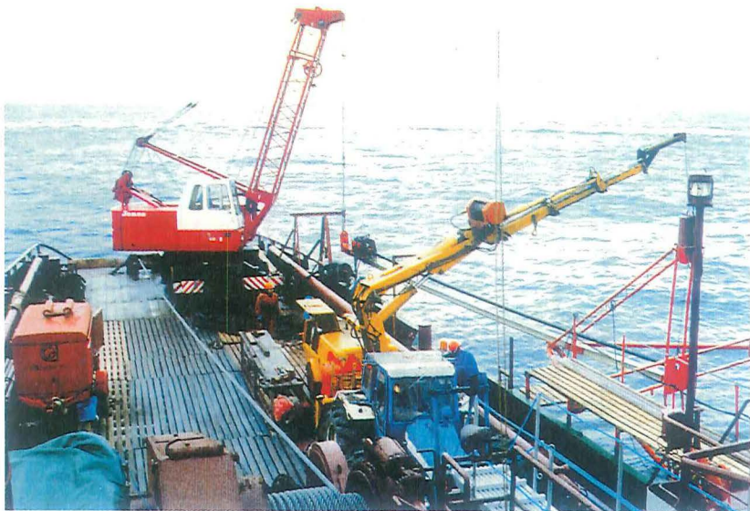
Dækket på boreskibet. Vibrocore boreriggen er udspændt mellem de to kraner.
