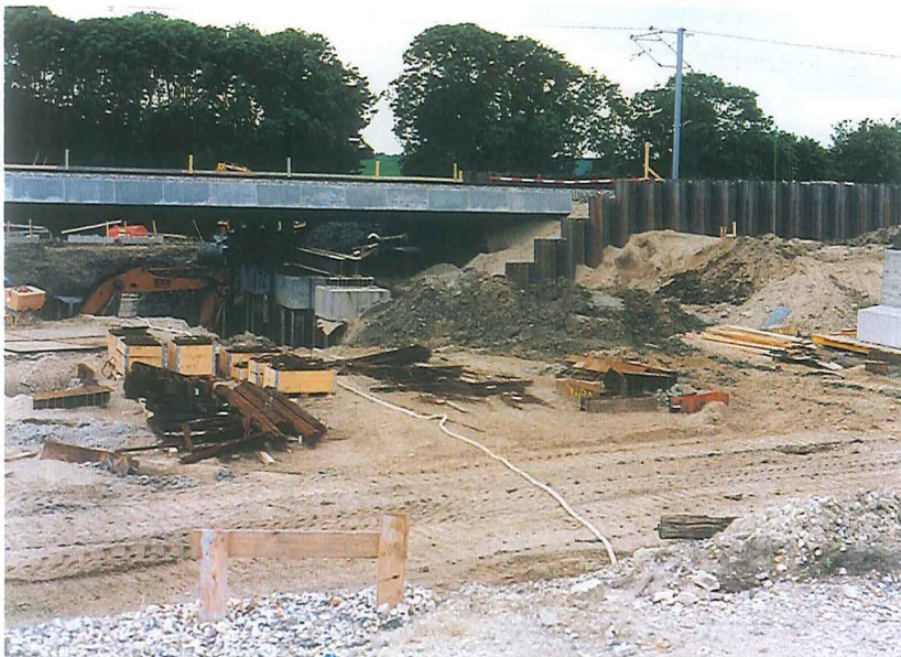
Figur 1. Foto af Tværvej-broen under konstruktion
