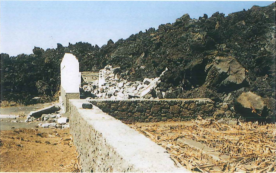
Figur 6. Aa-lavaen og vingården. Den 10-15 meter høje aa-lava knuste adskillige bygninger. Her står en hvidkalket mur af en vingård tilbage, medens resten enten er faldet sammen eller dækket af lavaen.
