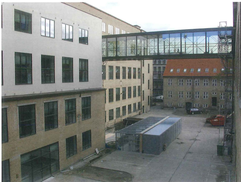
Geus' nybyggede kemifløj (forrest til venstre) og en ny gangbro som forbinder to af Geocentrets områder. Foto: J. Laurtrup
