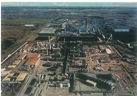
Figur 6. 'Great Plains Synfuels Plant' vest for Bismarck i North Dakota udleder store mængder røggas. Røggassen renses og CO 2 sendes i en 350 kilometer lang rørledning nordpå til Weyburn i Saskatchewan, hvor den injiceres i Weyburnoliefeltet for at forøge olieindvindingen (Sask. Energy and Mines).
