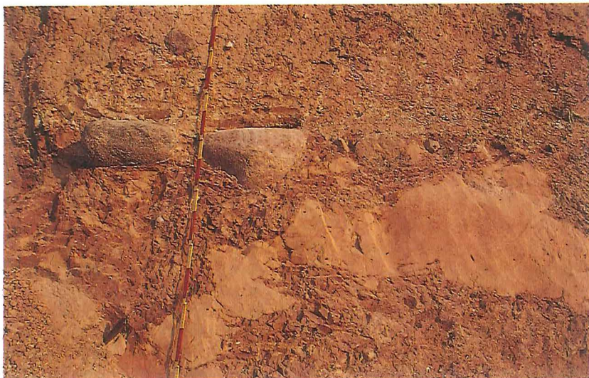
Figur 8. Rødbrun forvitret mellemste moræneler med sandlinser. Grænsen til øvre moræne vises af de to sten, der er skuret flade på oversiden. 360 meter på profilet fig. 10. Foto: 1979.
