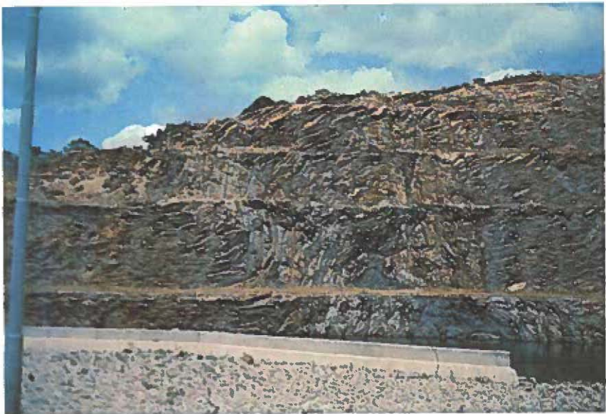
Stor fold (antiklinal) i Akwapim kæden ved Akosombo dæmningen. De foldede kvartsiter har været anvendt ved dæmningsbyggeriet.
