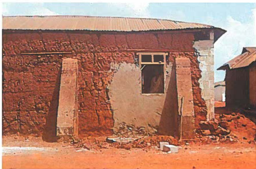
Hus bygget af laterit. Facaden er søgt stabiliseret med cement.
