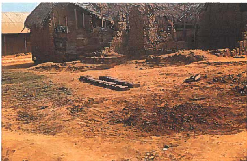
Hus bygget af laterit - delvis nedregnet. I forgrunden ligger mursten af laterit til tørre.
