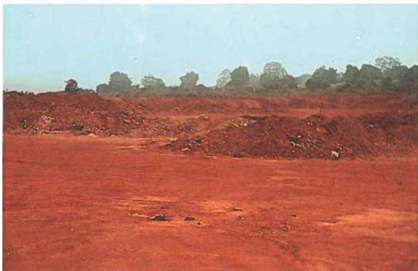
Laterit bunker skrællet sammen til vejmateriale
