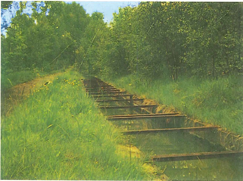
Denne kanal, "Rösche" var før dækket af brædder for at hindre sollyset i at nå planterne. Foto: Leif Carsrud.
