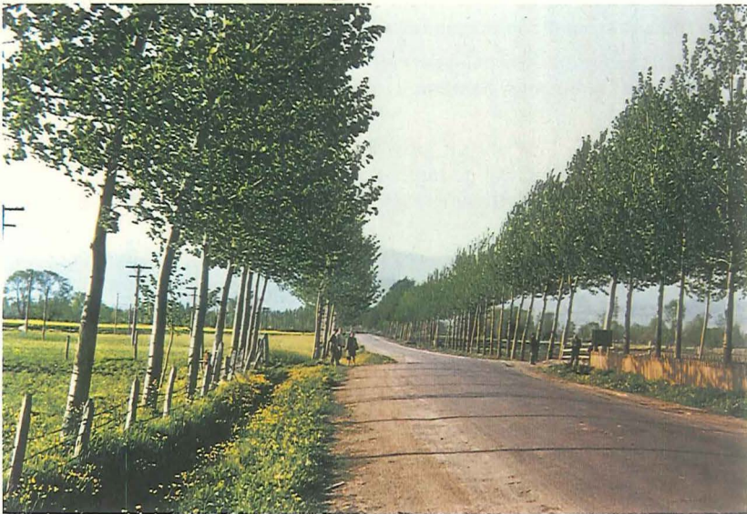
Landevej i Tyrkiet forsat sidelæns af tværgående jordskælvsrevne. N.Pavoni fot.
