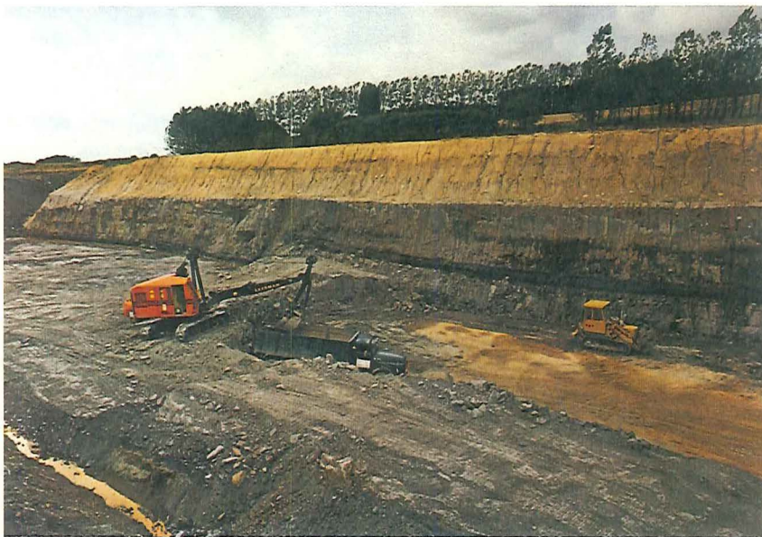
Figur 1. Lunnoms dagbrud, 20 km øst for Helsingborg. Höganäs AB fremstiller klinkerfliser af leret fra dette og andre dagbrud.
