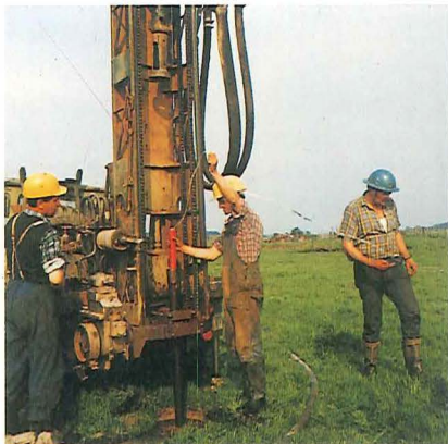
Figur 2. Efter sprænghullet er boret, sænkes ladningen ned.
