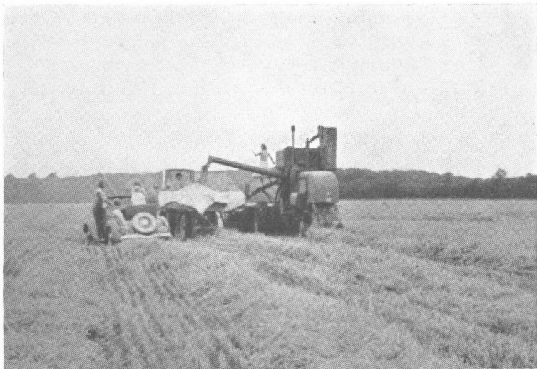
Fig. 1. Hjemtransporten af det aftærskede korn sker her på den måde, at det fra mejetærskerens tank løber direkte over i en almindelig kassevogn, forsynet med presenning.
