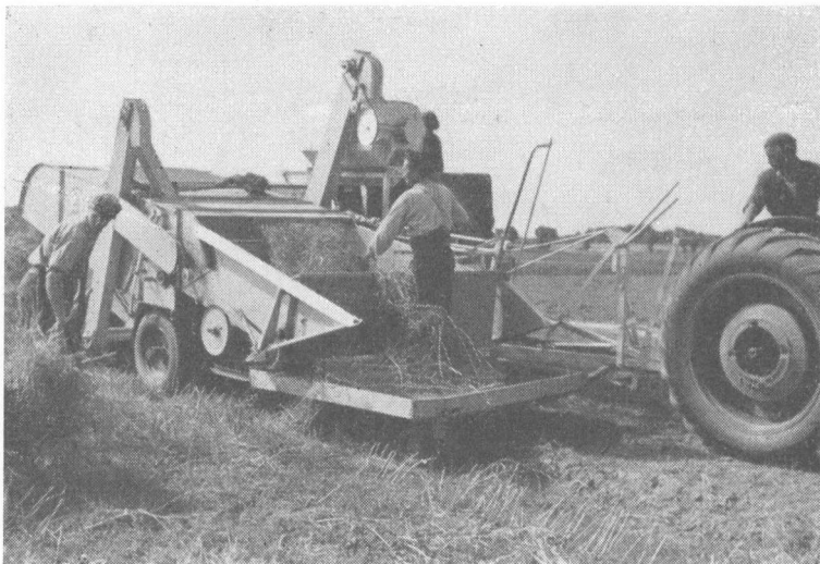
Fig. 4. Med et specielt bord med standplads bygget foran på mejetærskeren bliver denne særlig egnet til tærskning af hø fra hobe.
