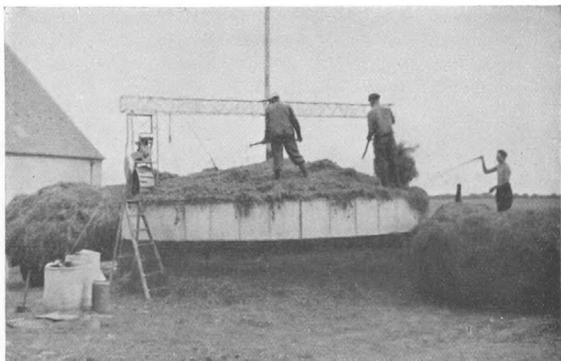
Fig. 2. Blokken begynder at tage form. Det store tryk skyldes ikke alene maskinens vægt, men også det stærke pres, der skal til for at hæve cylinderrammen.
