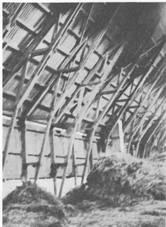
Fig. 4. „Hoby Boställe“. Staldloft indvendig med høj Trempel og Gittertagværk.
