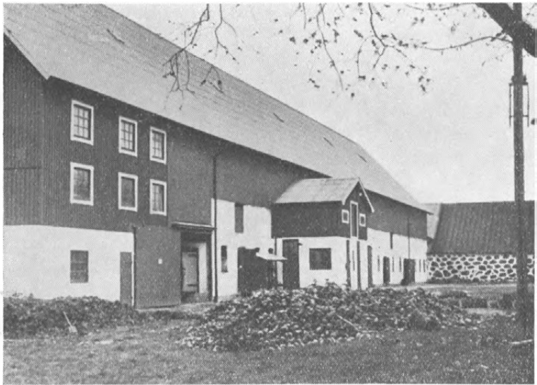
Fig. 1. „Hoby Boställe — en ældre, ombygget Gaard. Bemærk den høje Trempel. I Gavlen tilvenstre findes direkte Tærskelanlæg med Siloer. Indkørsel gennem Porten. I Udbygningen findes Rum for Mælkeafkøling og Spandevask.
