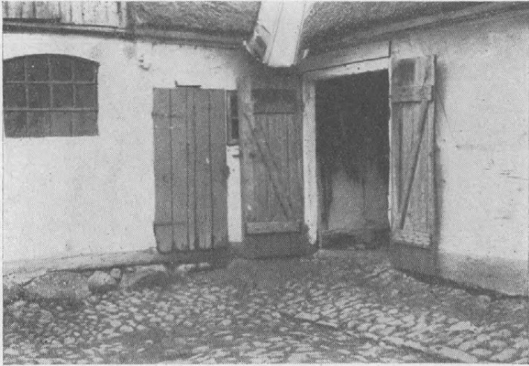
Fig. 3. Stalldøren i Krogen. Under Brand vil det være vanskeligt at redde Dyrerne, hvis der ikke findes Udgang paa Bygningens anden Side.
