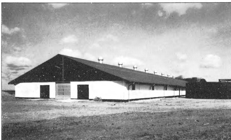
8 stk. FRISTAMAT type HDF-800 i stald med 220 malkekoer. Kapacitet: 56.000 m 3 /h. Projekt: Agrinova A/S, Næstved
