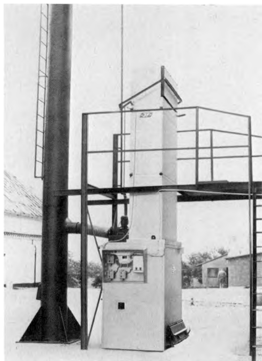
Fig. 5. JF's magasinfyrrer er her anbragt uden for bygningerne. Brandrisiko og brandforsikringspræmie, kan reduceres ved denne placering.
