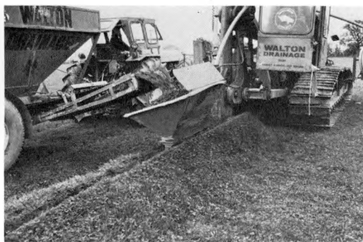
Fig. 25. Gravefri dræning i England. Sværdriller fyldes med slagge for at lette vandsivningen til rørene.
