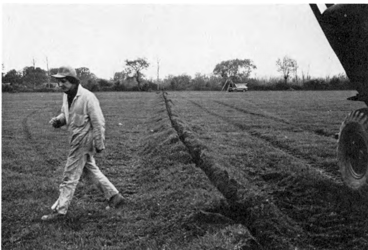
Fig. 26. Markens udseende umiddelbart efter nedlægning af drænrør med
