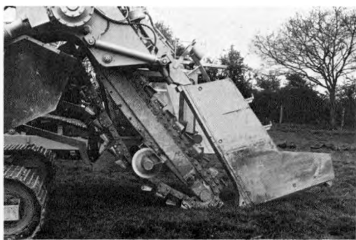
Fig. 21. Kædegravemaskine til nedlægnings af drænrør.
