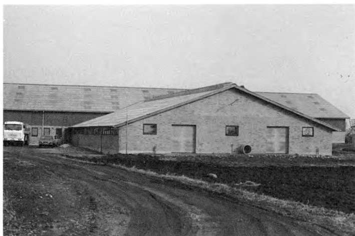
Fig. 1. Forsøgsstald A, en isoleret 4-rækket bindestald. Stalden blev udstyret med automatisk styrede indsugningsklapper og hævespjæld over kippen. Til højre øverst: nærbillede af indsugningsklapper. Til højre nederst: nærbillede af hævespjæld i åben stilling.
