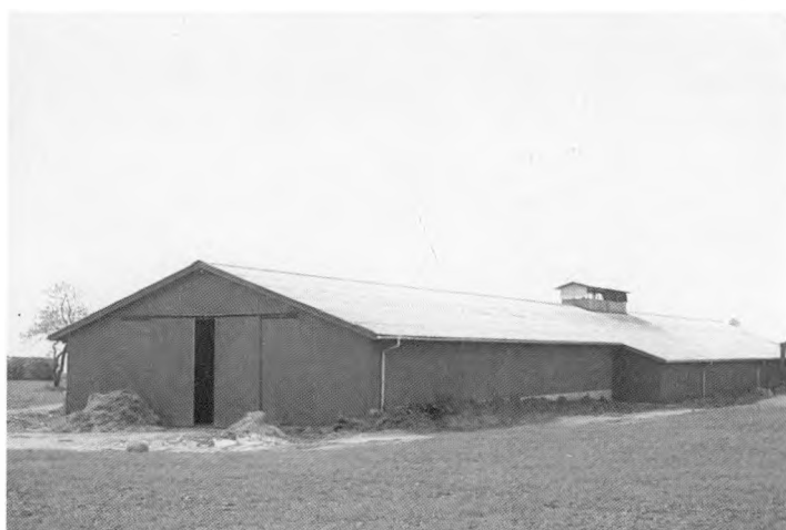
Fig. 3. Forsøgsstald C, en isoleret sengestald med en separat, smallere ungdyrstald i forlængelse af kostalden. Stalden blev udstyret med automatisk styrede indsugningsklapper og en aflukkelig central skorsten. Til højre øverst: nærbillede af udsugningsklapper. Til højre nederst: nærbillede af den centralt placerede skorsten.
