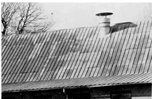
Fig. 6. For at opnå et godt resultat skal pladerne renses og grundes før de males.
