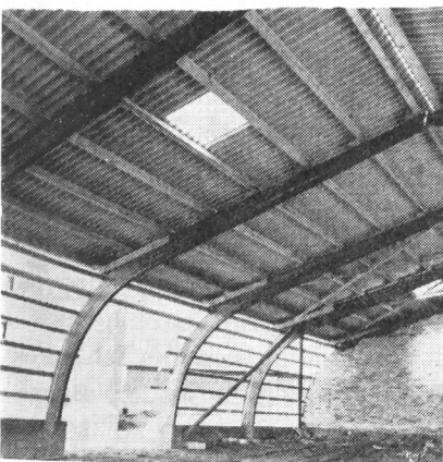
Laminerende buer opsat som rammen om en ny løsdriftstald. (Fra Landbrugets Byggebog. Foto: LIK).
